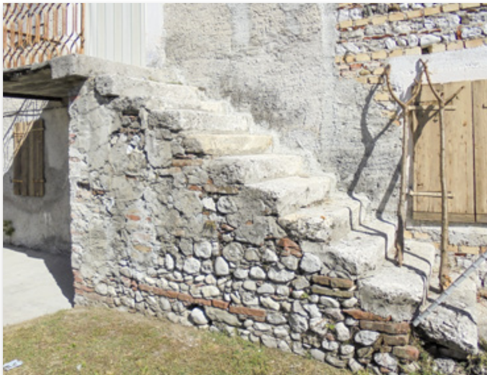
■ Ovoledo, for di Dreùssa , punto E/24. Secondo l'informatore il forno era ospitato nel sottoscala, accessibile dall'interno della casa. (foto Nerio Petris)
