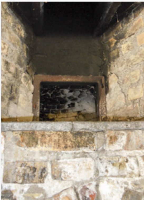
■ Ovoledo, for di Bòrtul , punto E/22. Particolare bocca di accesso alla volta in mattoni della camera di cottura. (foto Nerio Petris)
