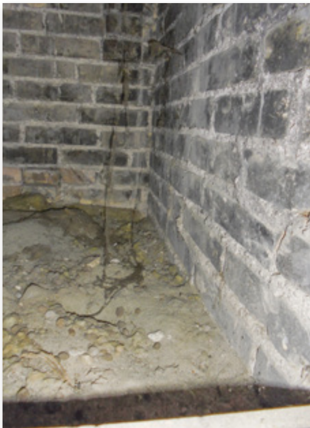
■ Zoppola, for di Tesàn , punto E/7. Particolare della sabbia distesa sopra la volta della camera di cottura. (foto Nerio Petris)
