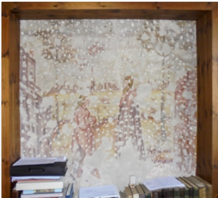
■ Poincicco, località Policreta, punto E/74. Casa-palazzo cinquecentesco già dei Policreti (ora Biancolin), sala da pranzo. Lacerti d'affresco venuti alla luce in fase di recupero e risanamento conservativo. (foto Nerio Petris)
