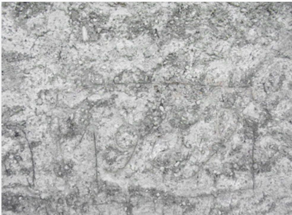
■ Zoppola, casa di Risi lato nord, punto E/19. Particolare graffito su malta fresca attestante l'anno (1909) di ristrutturazione del caseggiato. (foto Nerio Petris)
